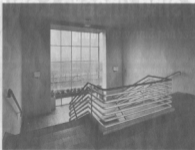
Architekturstudie: Werner Mantz, „Treppengeländer im Treppenraum“, 1928. Foto: Bildz
